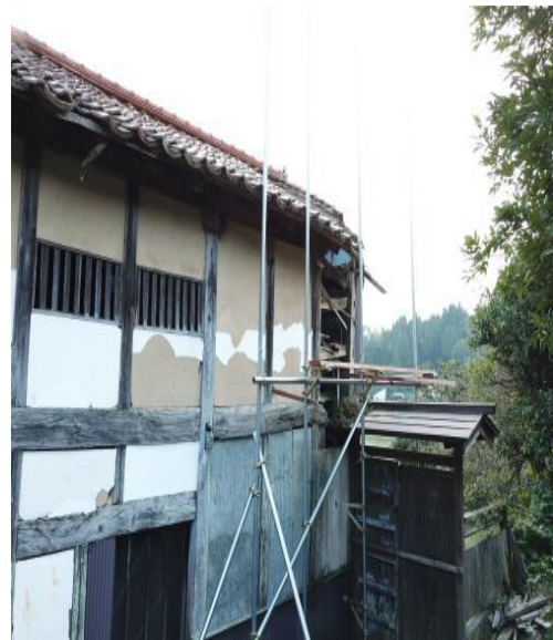
図3 修繕中の古民家
