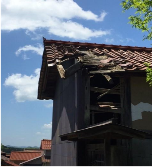
図1 修繕する古民家
